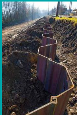
Le "rideau" de palplanches, une fois enfoncé dans le sol, à la digue de Barraux.
