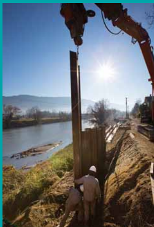
La mise en place des palplanches sur la digue de Barraux.
