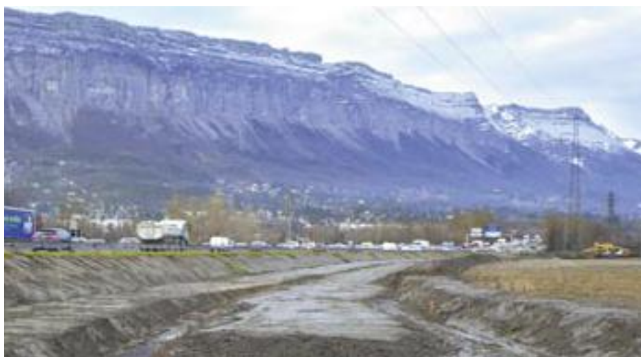
Ici, en bordure de l'autoroute, un merlon est aménagé. Il constituera la limite du champ d'inondation contrôlée de La Taillat.
