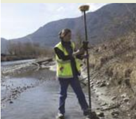
Opérations de contrôle topographique sur les travaux du Symbhi.
