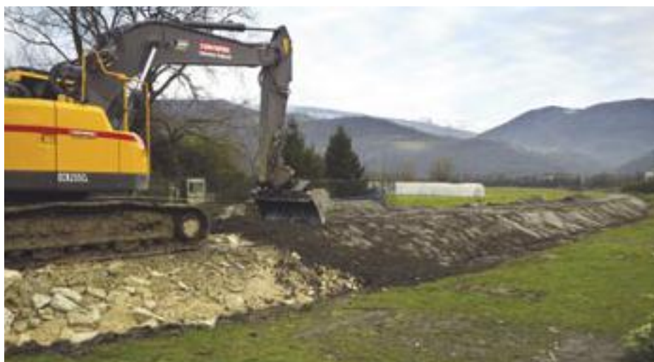
Constitution d'un remblai destiné à protéger une habitation de la plaine de La Taillat.
