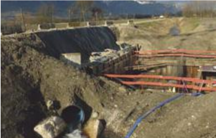
Pour aménager la station en travers du canal, l'eau de Cheminade a été provisoirement déviée.
