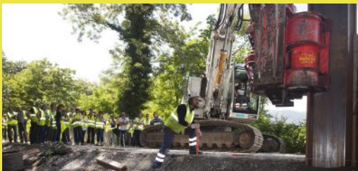
Les agents du Conseil général ont pu assister à la pose de palplanches sur la Taillat.
