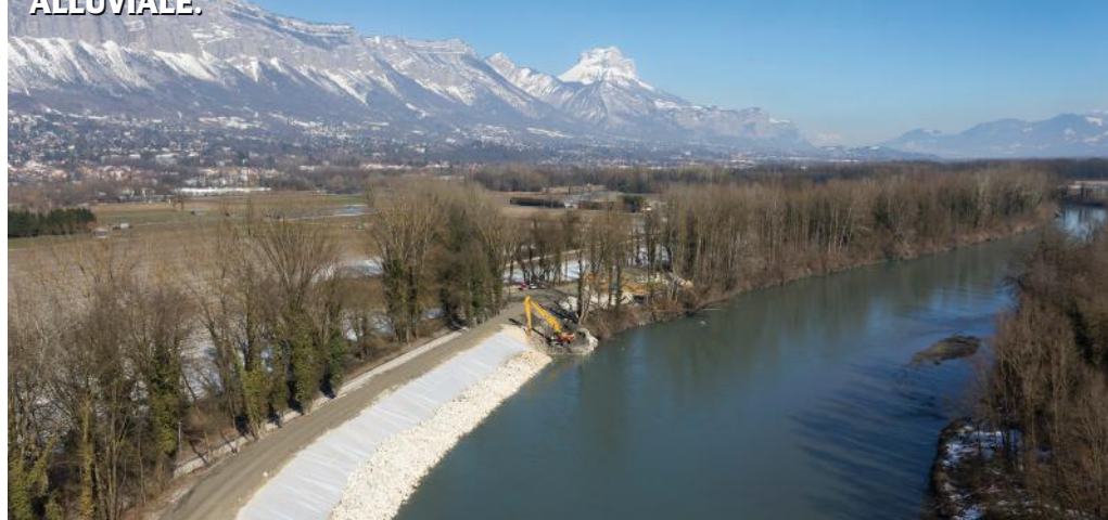
Vue aérienne des travaux de pose d'enrochements sur la commune de Meylan, entre la base vie Paquet et le plan d'eau de la Taillat.
