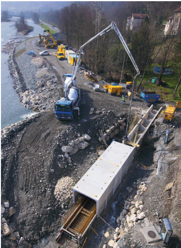
Les travaux de la passe à poissons du ruisseau de la Touche, l'un des sujets évoqués lors du dernier Comité consultatif.
