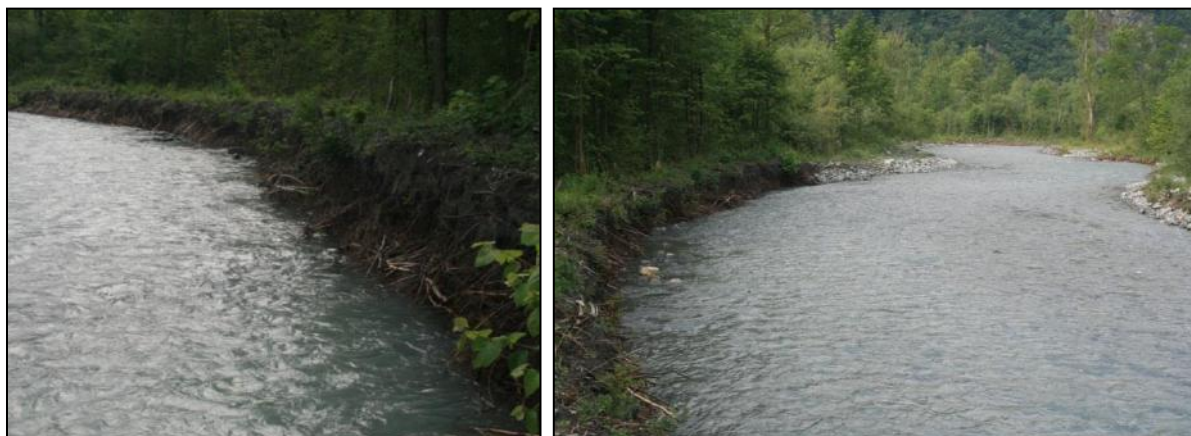
Front d'érosion et sinuosités sur le bras n°1 en eau (Juin 2014).
