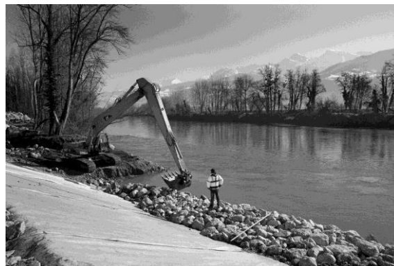
Figure 7 : Photo terrestre des travaux sur l'Isère
