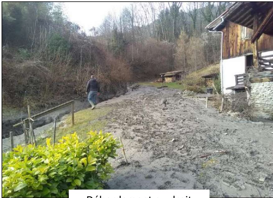
Débordement au droit d'une habitation
