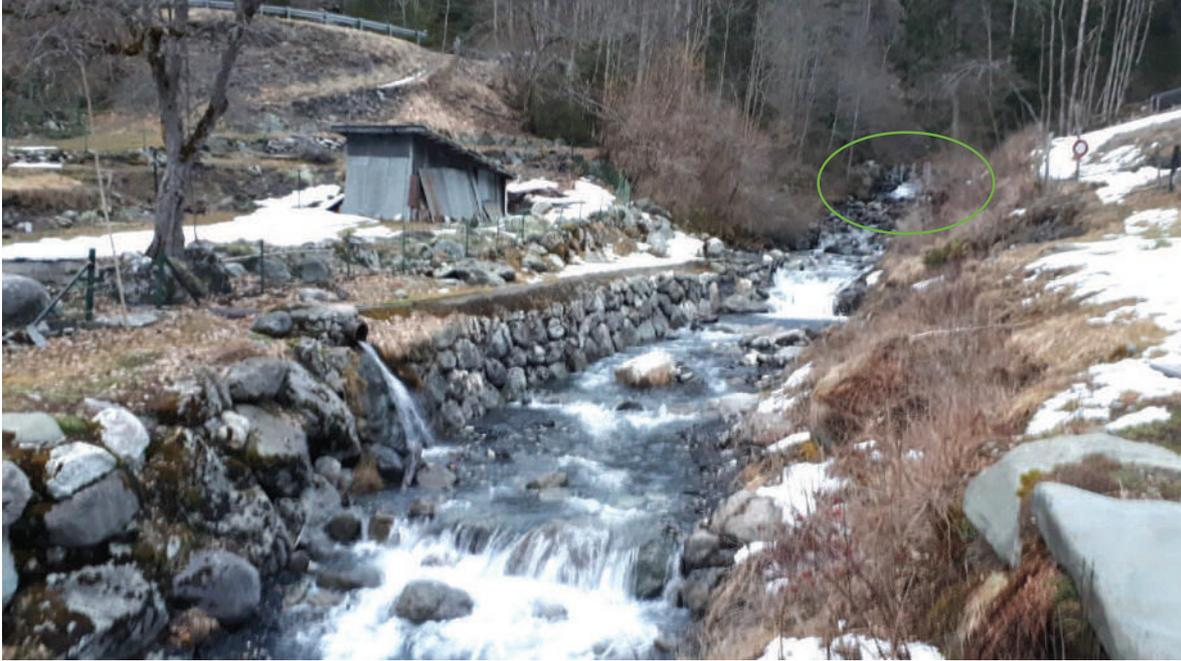
*Vue du torrent de la Muzelle, de l'aval vers l'amont, avec piège à embâcles entouré en vert*
