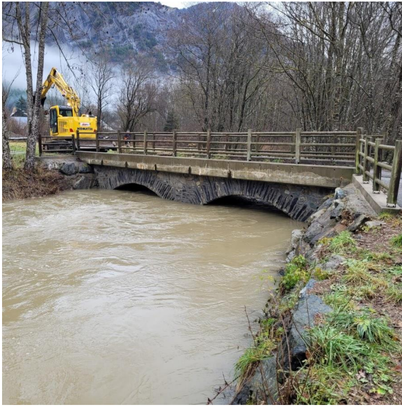
Photo 4 : curage d'urgence du pont de Bassey sur la Sarenne à Bourg d'Oisans lors de la crue du 11 décembre 2023
