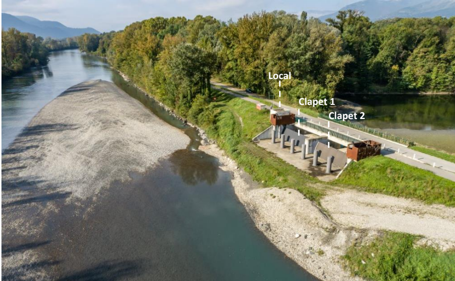
Ouvrage de St-Ismier Bois Français amont
