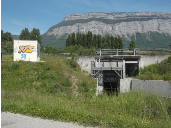
Vannes de Jaillières
