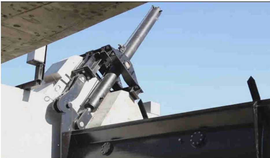
Vue aval d'un clapet et de son système de manœuvre
