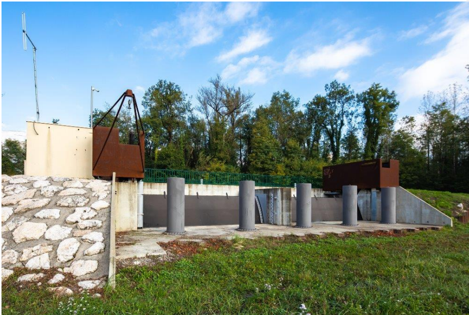
Vue rapprochée des clapets (1/2)
