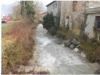
Les futurs aménagements visent à protéger les personnes et les biens d'une crue cinquantennale. Photo Le Di
