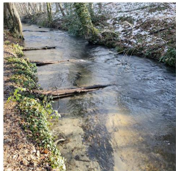
EXEMPLE DE DÉFLECTEURS EN BOIS FAVORISANT LA DIVERSITÉ DES ÉCOULEMENTS ET DES SUBSTRATS (FURE, 38)
