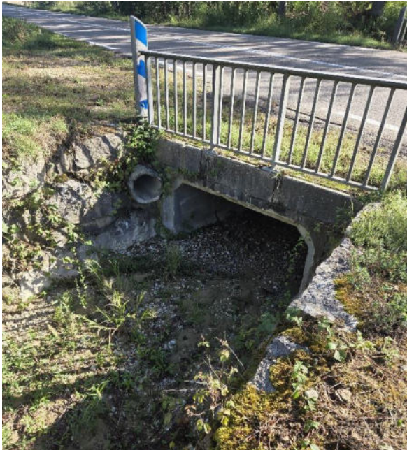
Figure 7 : Dalot de franchissement de la RD1092
