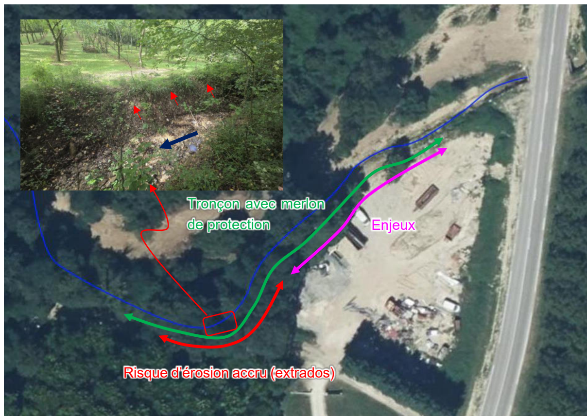
Figure 14 : Justification de la nécessité de protection de la rive droite en aval de la plage de dépôt
