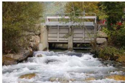
A Vizille, au niveau de la confluence du canal dit "du Tolentin" et de la Romanche, un équipement complexe a été installé fin septembre 2013. L'opération a consisté à adapter deux vannes automatiques à commande par ultrasons sur la structure en béton existante et à reprendre légèrement l'ouvrage de génie civil. Désormais toujours ouvertes, les vannes ne se fermeront qu'en cas de crue, pour éviter toute remontée de l'eau de la Romanche dans le canal usinier.
