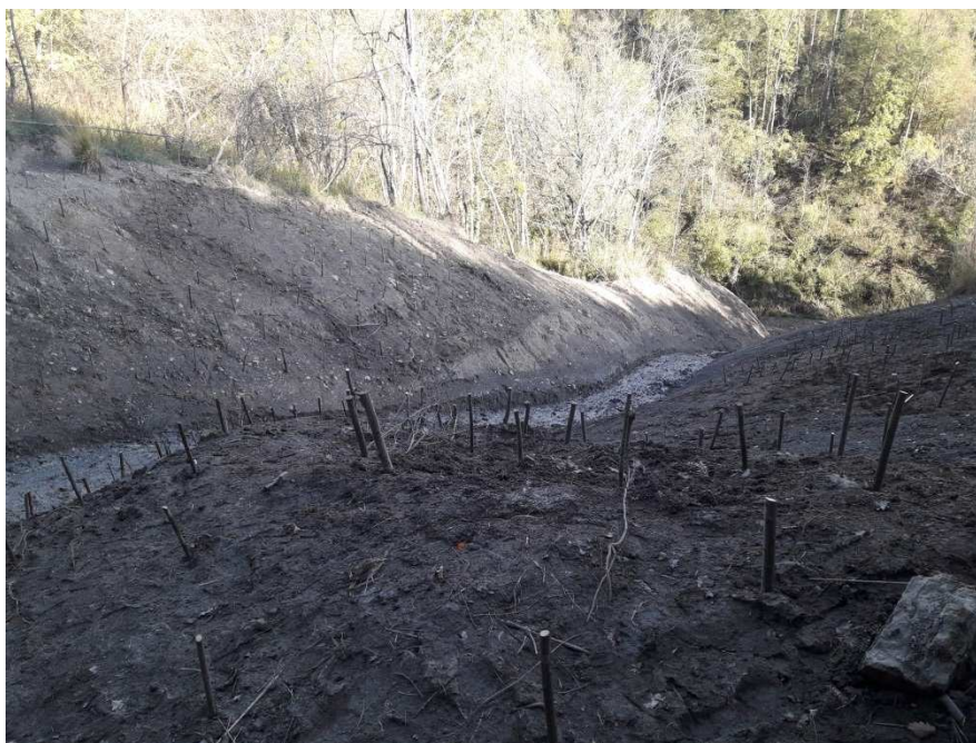
Stabilisation du versant sur le Rif Mort par une technique de génie végétale
