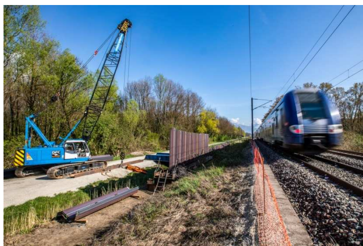
Travaux spectaculaires sous l'autoroute et de renforcement du talus SNCF
