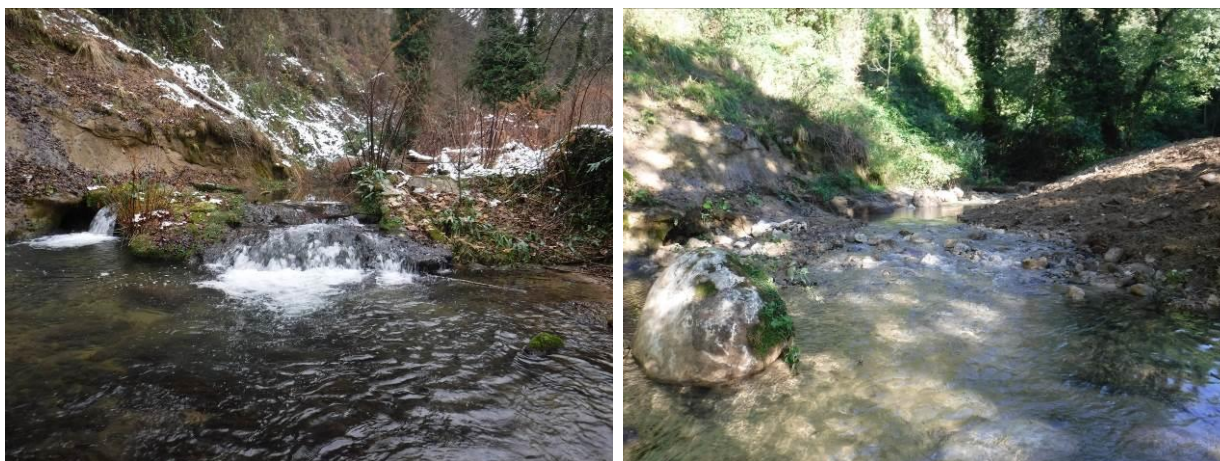
Figure 5 : Effacement d'un seuil créant un obstacle à la continuité écologique sur le ruisseau du Tréry. Photos avant/après travaux.
