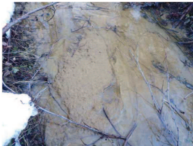
Remblai en rive droite ; Matériaux sableux introduit dans le Vézy par ravinement du remblai
