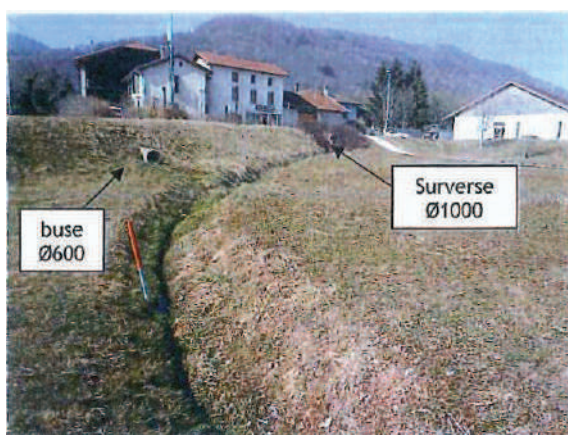
A gauche : chenal en aval de l'ouvrage de décharge (diam. 1000) et du réseau d'eau pluviale (diam. 600) ; A droite : bief après la confluence entre le chenal de décharge et le chenal principal (au niveau du lotissement).
