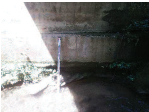
En haut à gauche : Secteur amont (fond tenu par de petits seuils) ; en haut à droite : Secteur incisé en amont du pont de Barnetière (notons que les berges contiennent des galets) En bas à gauche : Culée du pont de Barnetière affouillée ; en bas à droite : Muret (en amont du pont) affouillé
