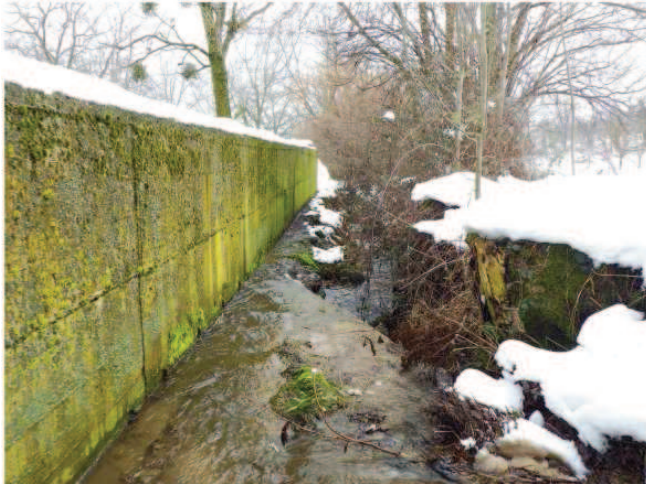
Seuil de stabilisation ; Affouillement des murs en aval
