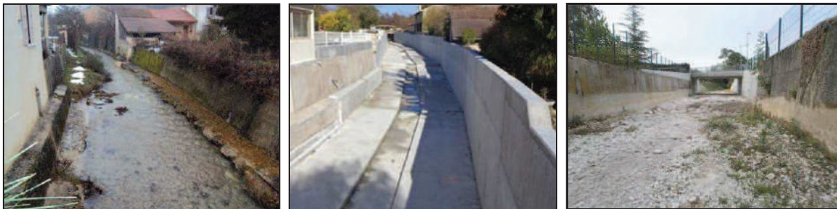
Avant et après l'aménagement du lit de Merdaret entre le pont de la D27 et la passerelle ; réfection du pont Pré Jean Gour
