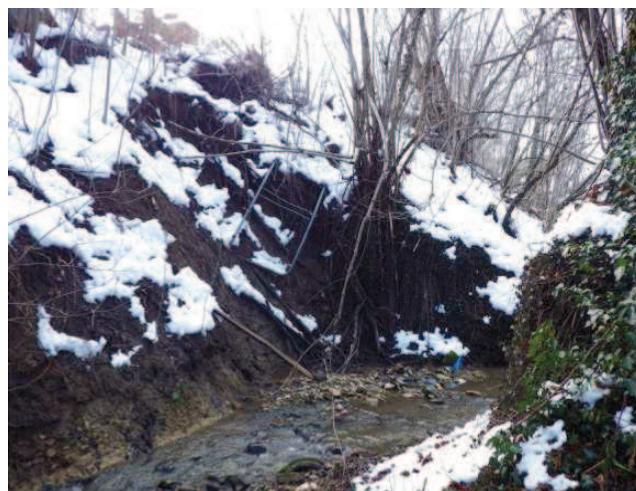
Affouillement des berges de la décharge
