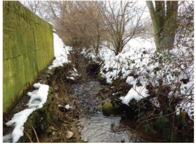
Seuil de stabilisation ; Affouillement des murs en aval
