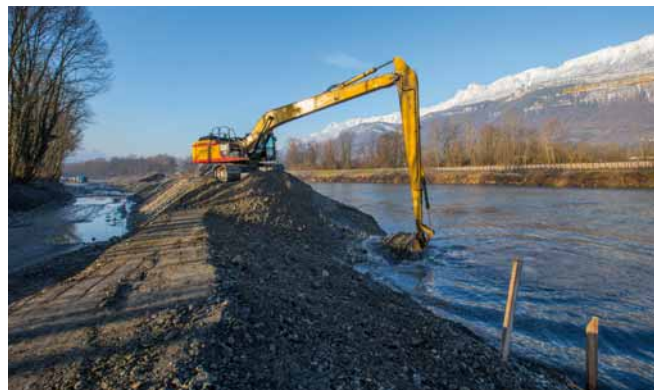
Arasement d'un banc de l'Isère à Pontcharra.
