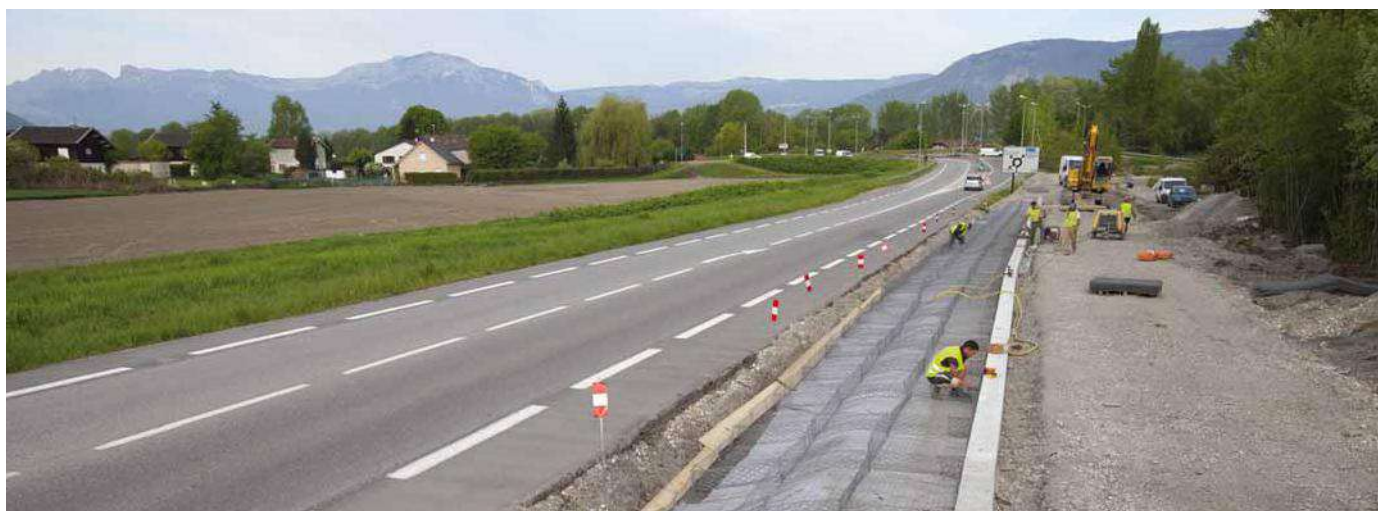
Exemple de réalisation d'un déversoir de sécurité à Domène (tranche 1).
