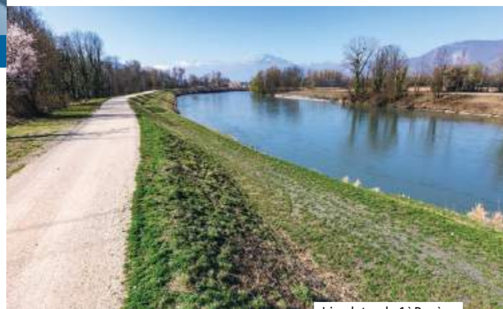
Ici sur la tranche 1 à Domène.
