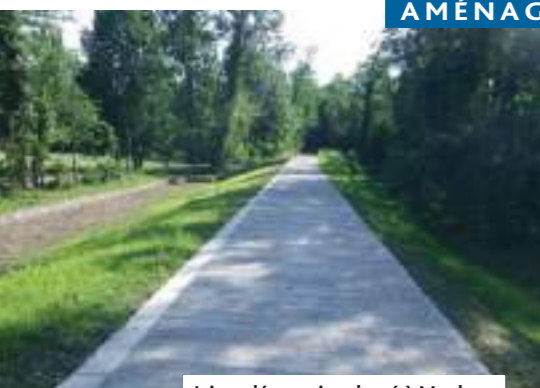
Ici un déversoir achevé à Meylan.
