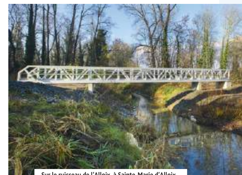
Sur le ruisseau de l'Alloix, à Sainte-Marie d'Alloix, la passerelle épargne aux piétons un grand détour.
