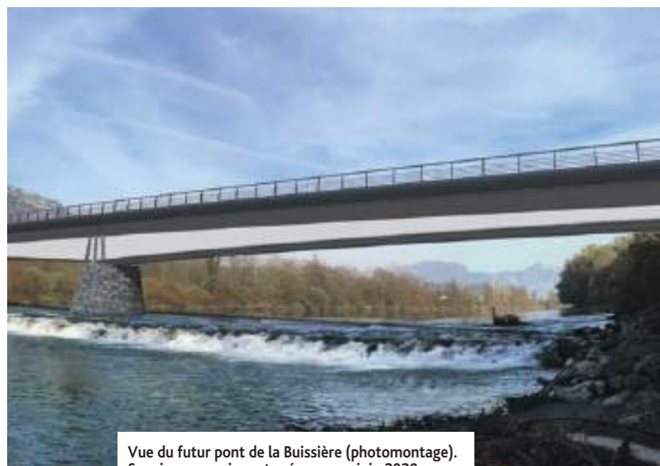
Terminé en 1877, le pont de la Buisnière reposait sur quatre piles. Il permettait le passage de près de 2 000 voitures par jour, jusqu'à ce que, le 1 er mai 2013 au soir, la quatrième pile du pont de la Buisnière s'enfonça de 75 cm.
