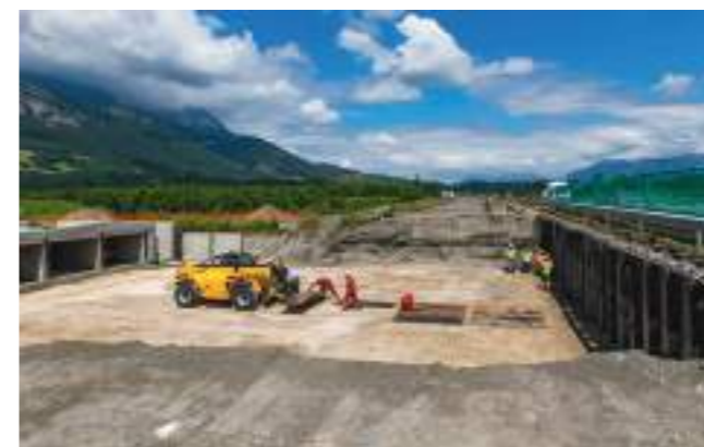
La circulation de l'autoroute a été maintenue tout au long des travaux, et pendant 4 semaines, réduite à deux fois une voie, comme sur cette photo, où la partie droite des voies a été démontée. La première moitié de la conduite est sur le point d'être poussée à cet endroit.
