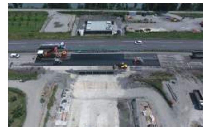
En bas, l'insertion de la première moitié de la conduite est réalisée et la chaussée de l'autoroute est en court de réfection. En haut, la seconde moitié de la conduite est finalisée et est en attente d'être poussée.
