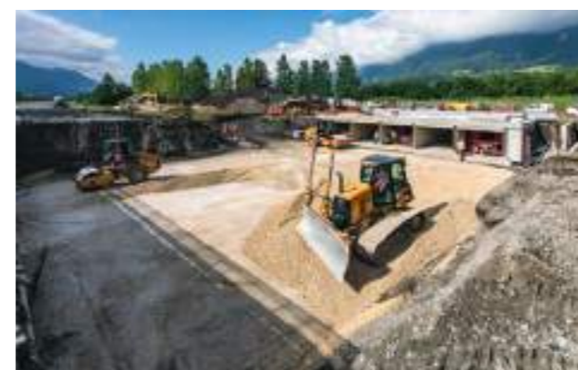
Avec son gabarit de 29 mètres de long et 19 mètres de large, l'ouvrage hydraulique est constitué de 5 cadres béton. Il a été construit par moitié sur les terrains de part et d'autre de l'autoroute.
