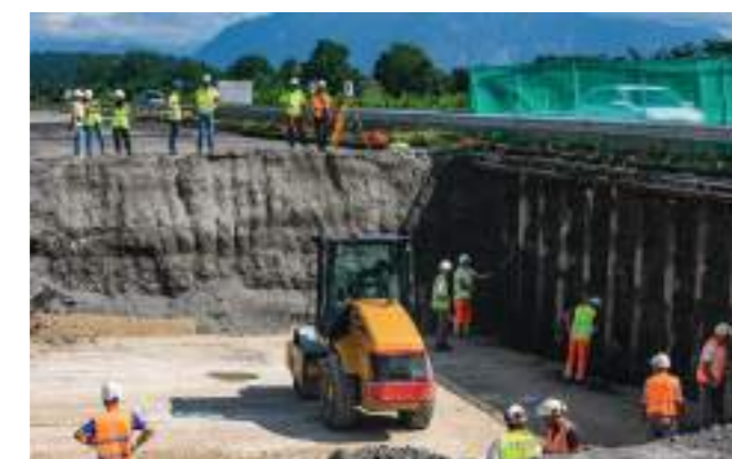
À droite, la paroi est constituée de palplanches, insérées entre les deux voies de l'autoroute à l'été 2018, en prévision des travaux. Ces parois d'acier soutiennent l'autoroute le temps de l'insertion des conduites.
