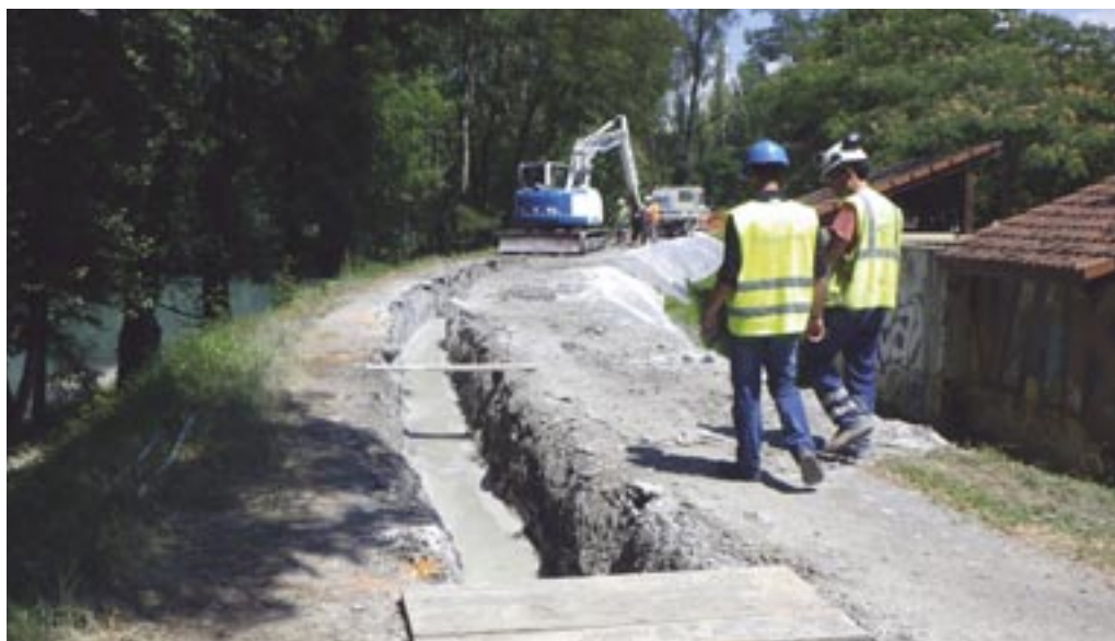
Coulis de ciment-bentonite déversée dans la tranchée creusée sur la piste du domaine universitaire.
