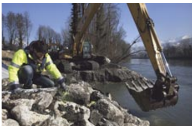
Opérations de vérification de la pose des enrochements à Meylan.
