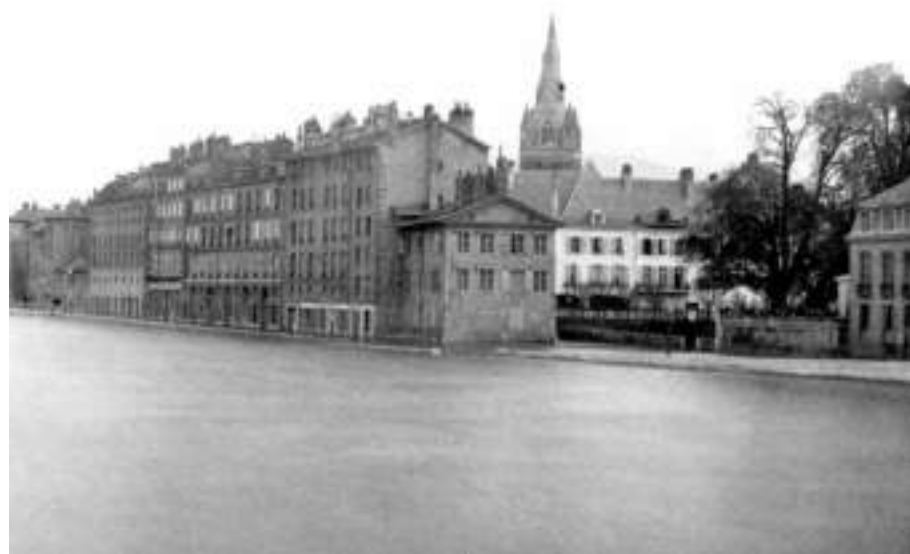
Quai de Grenoble.
