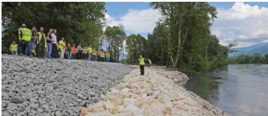
Isère amont, un projet qui suscite l'intérêt de nombreux visiteurs.
