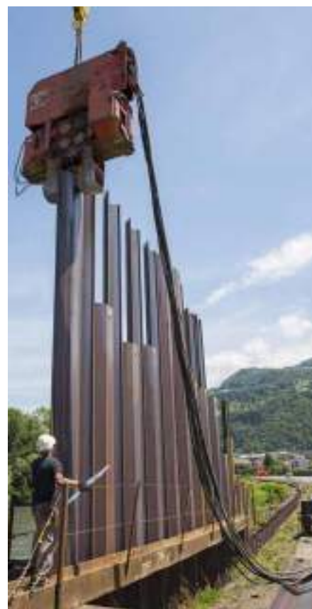
À la manœuvre pour la mise en place des palplanches.
