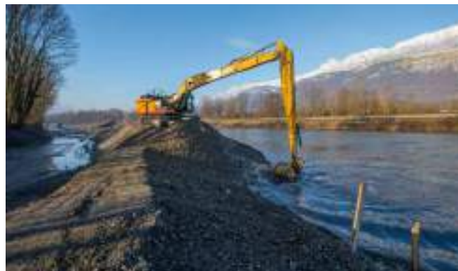
Arasement d'un banc de l'Isère à Pontcharra.
