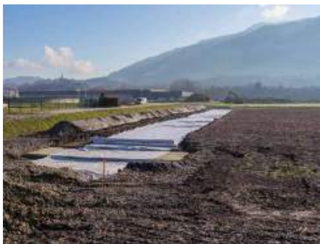
Préparation du merlon de protection de la zone de Pré Brun, à Pontcharra.
