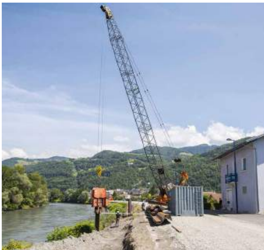
Le chantier de pose des palplanches à Villard-Bonnot.
