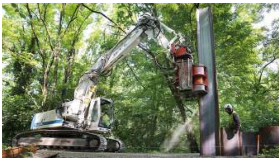
Pose d'une palplanche à Meylan.
