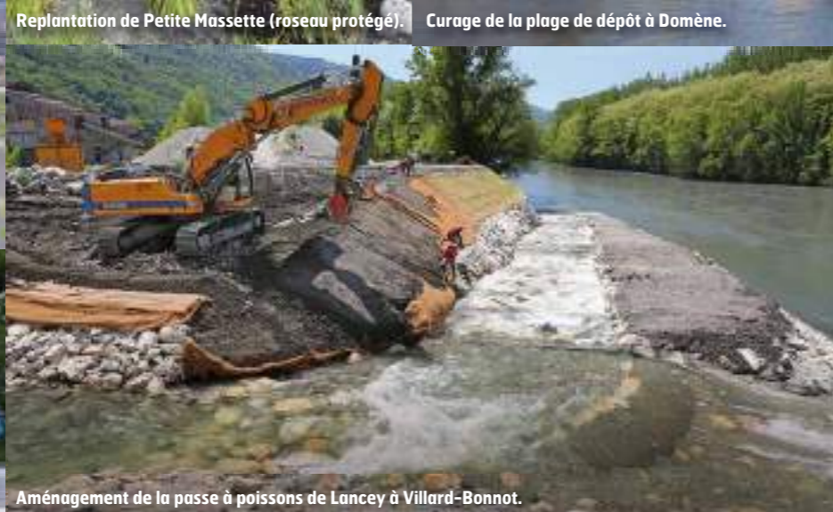
Pose d'enrochements à Meylan.
