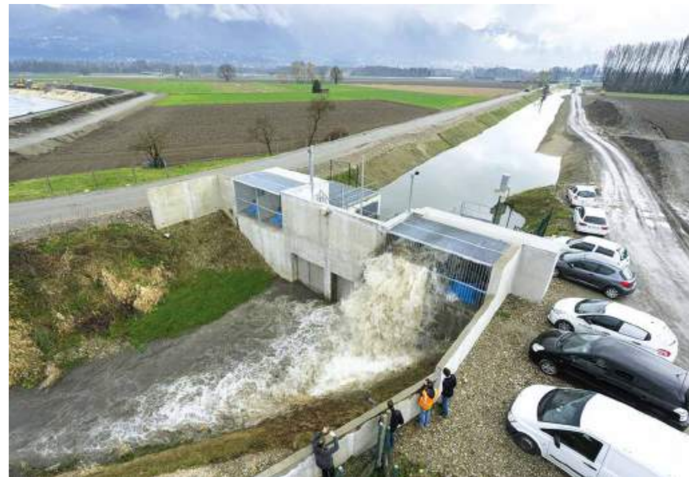
Test de fonctionnement des pompes de la station de Cheminade.
