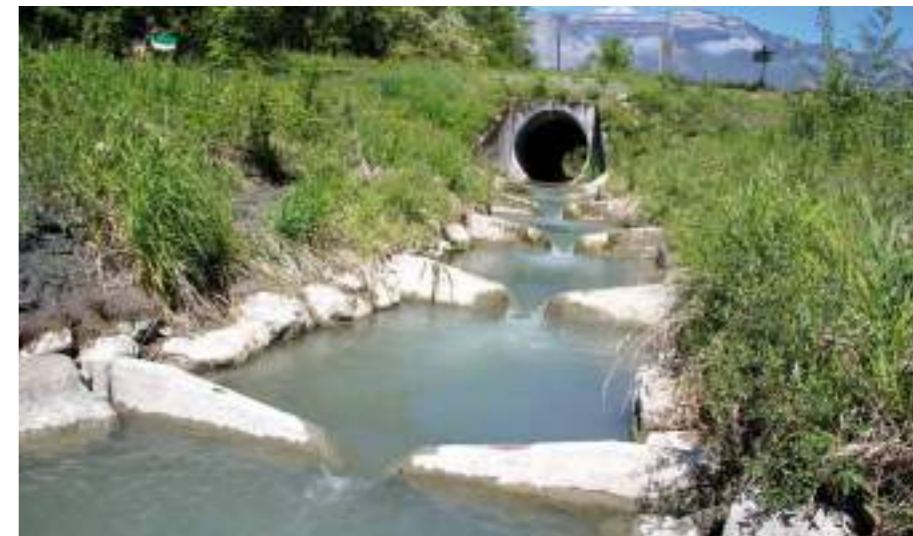
Connexion piscicole du canal de Bois Claret à l'Isère par une passe à bassins.
