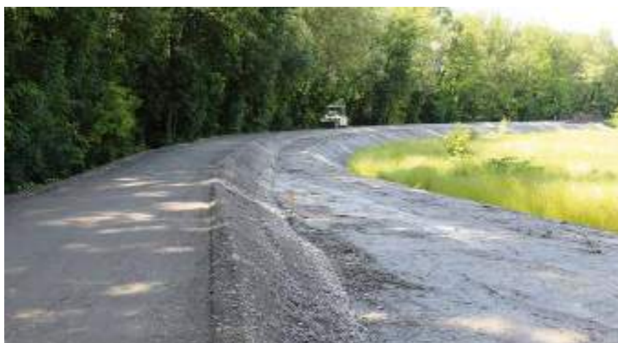
Elargissement de digue à Meylan.
