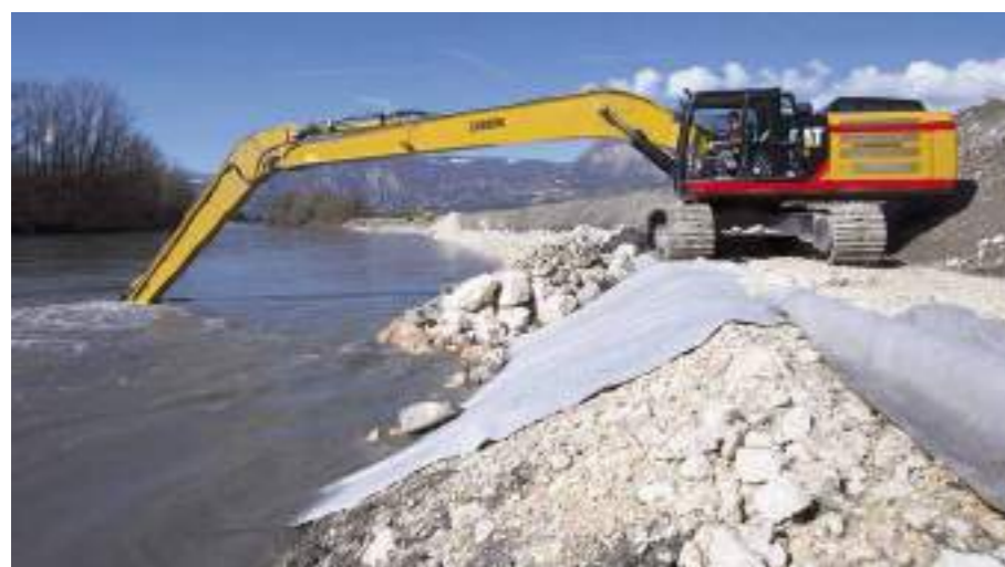
Pose d'énrochements à Gières.
