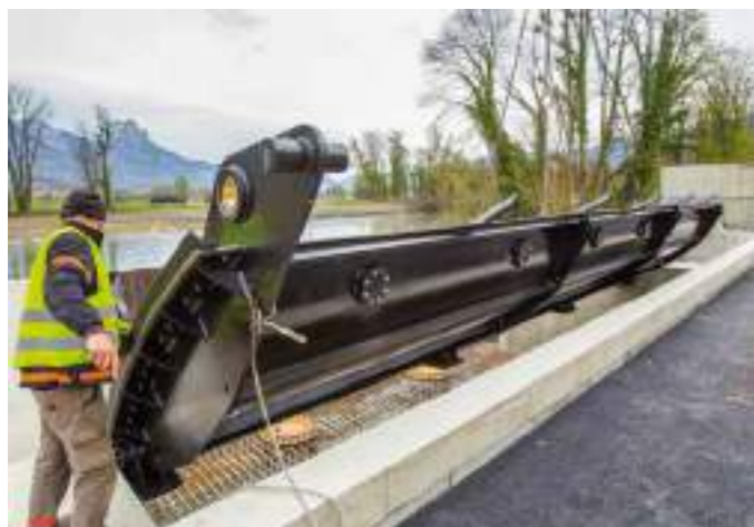
31 mars 2016, à Murianette, les clapets sont installés sur la digue. À droite, l'ouvrage terminé.
