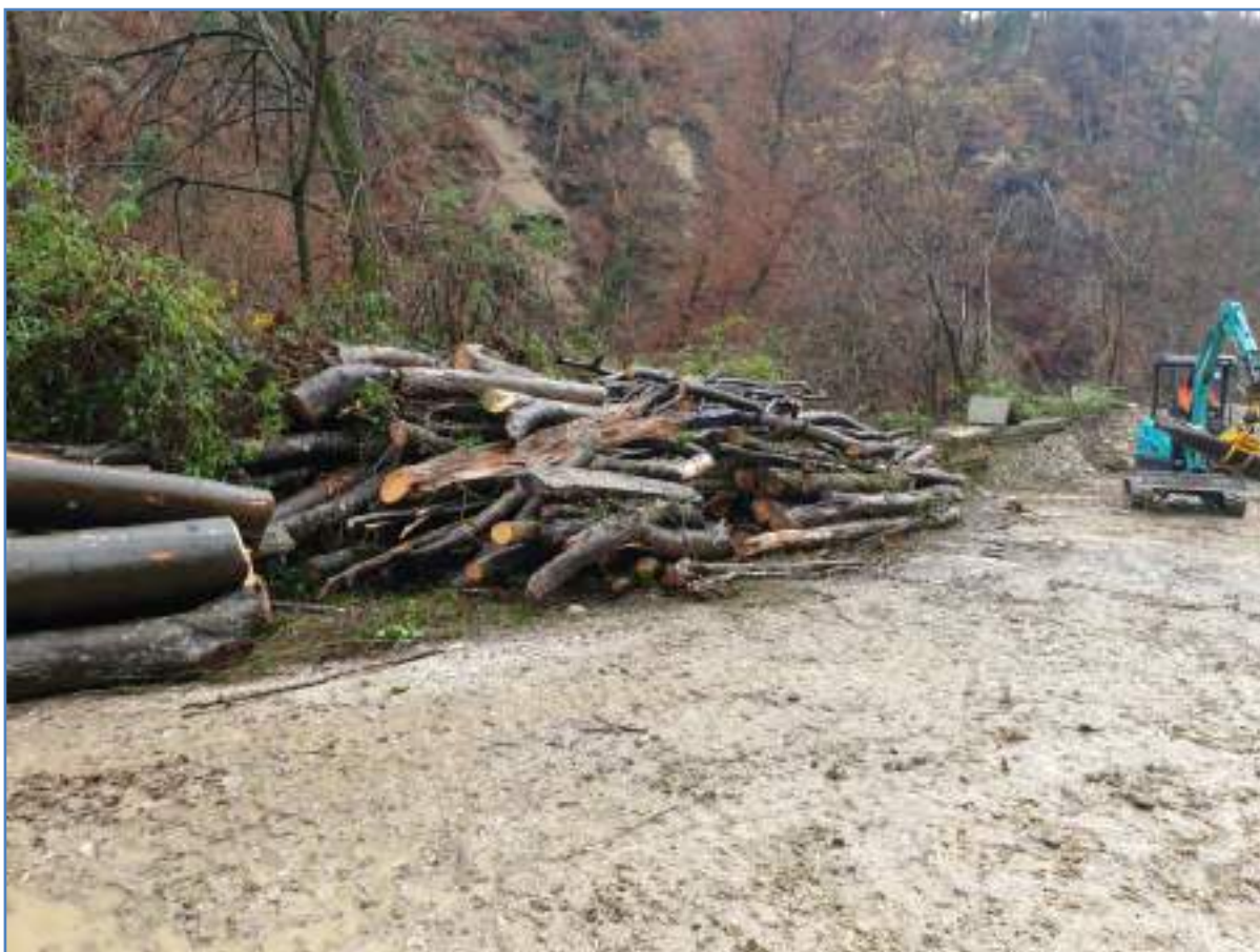
Intervention - Stockage bois évacués - Plateforme ancienne papèterie
