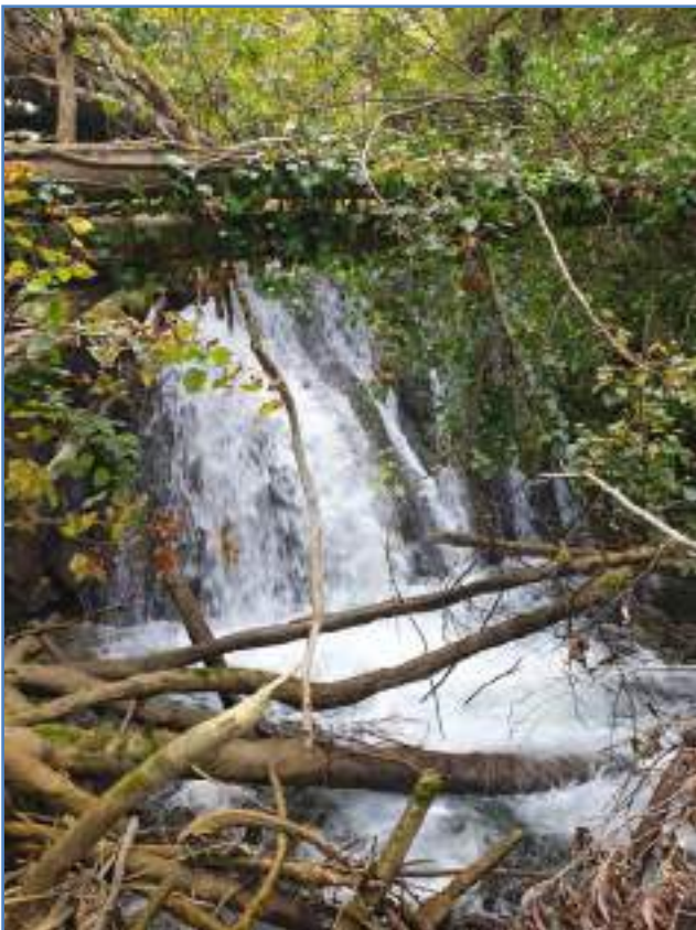
Embâcle - Lit de la Morge - Chute d'eau ancienne papèterie
