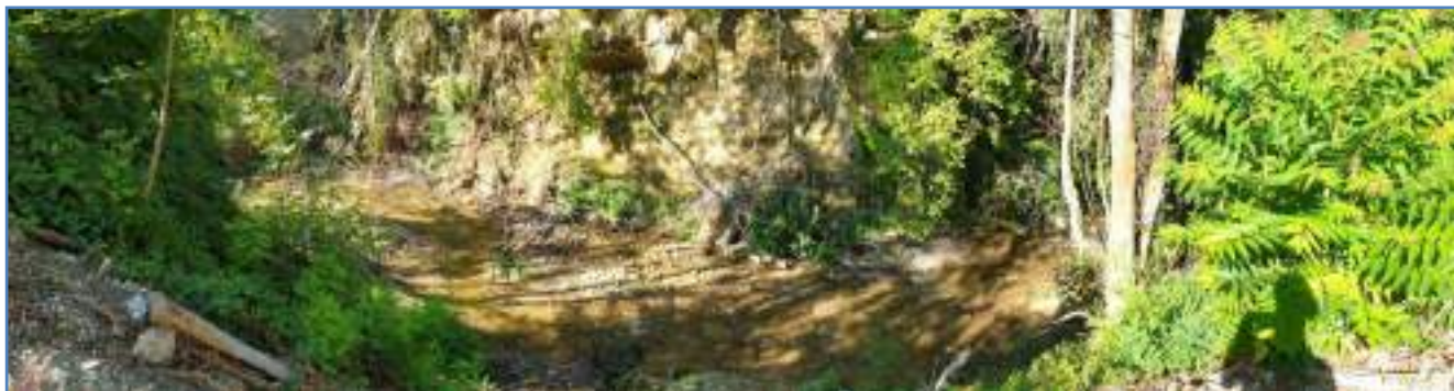
Rétablissement section d'écoulement - Amont Chute d'eau ancienne papèterie
