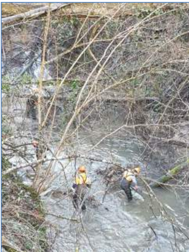
Intervention - Aval chute d'eau (ancienne papèterie)
