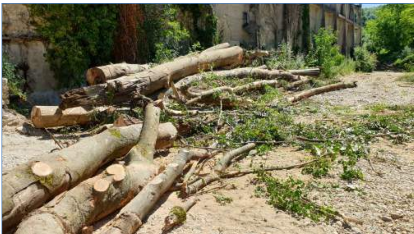
Intervention - Stockage bois évacués - Plateforme ancienne papèterie
