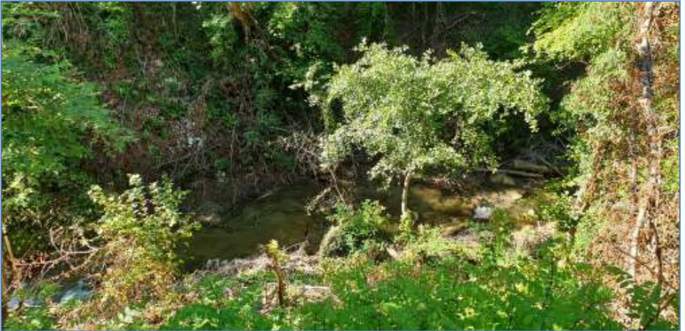
Rétablissement section d'écoulement – Amont ancienne papèterie
