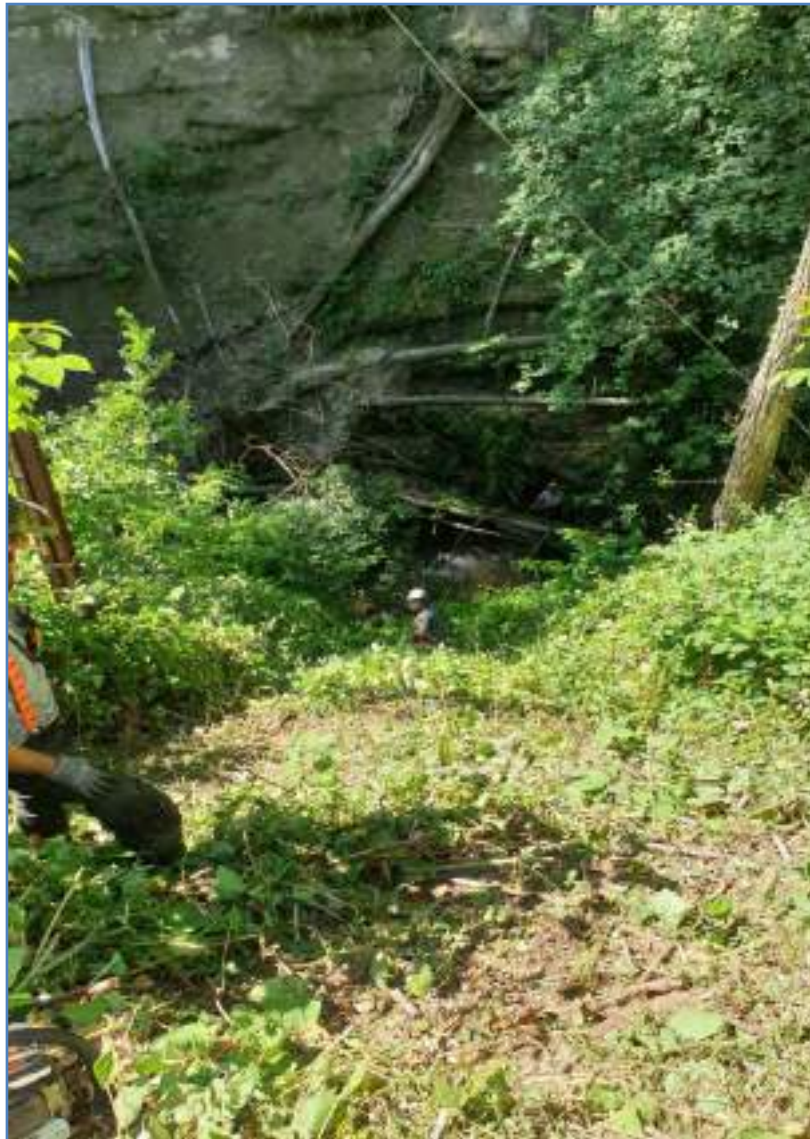
Intervention - Aval « Carrosserie voironnaise »
