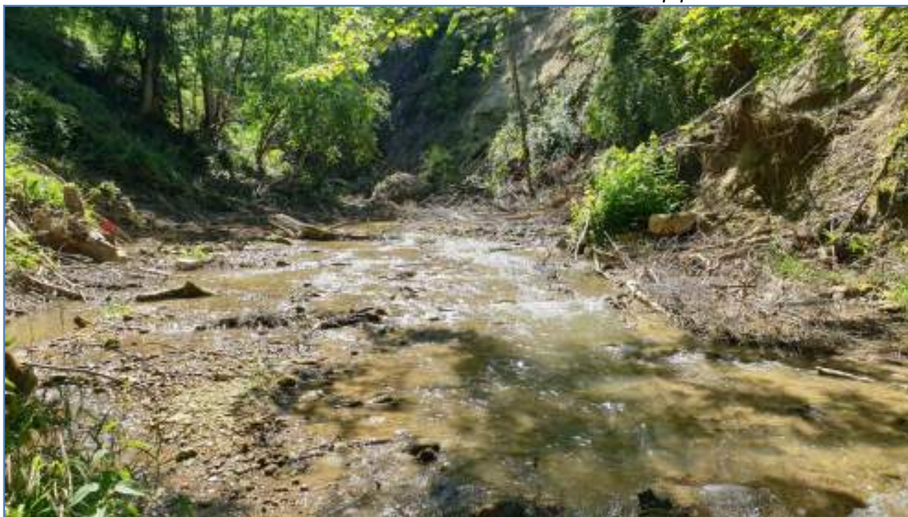
Rétablissement section d'écoulement - Amont Chute d'eau ancienne papèterie
