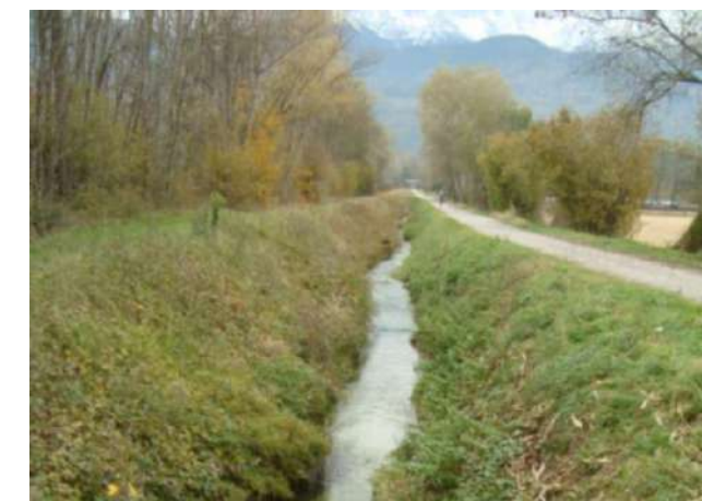
Figure 28 : Chenalisation du torrent de Crolles dans sa traversée de la plaine de l'Isère (Source : EGIS Eau)
