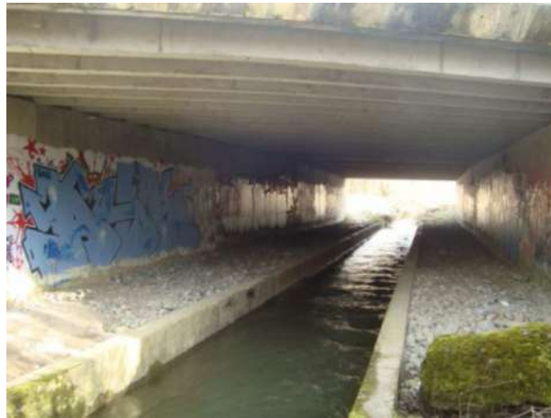
Figure 29 : Franchissement du Glandon par l'autoroute (Source : EGIS Eau)
