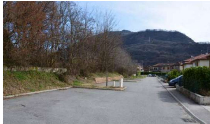
Figure 32 : Endiguement du ruisseau du Salin en aval du Cheylas
