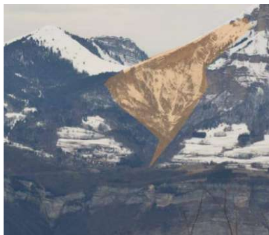
Figure 26 : Tête de bassin versant du torrent du Craponoz avec versant fortement altéré connecté au bief principal (torrent de la Gorgette) (Source : EGIS Eau)
