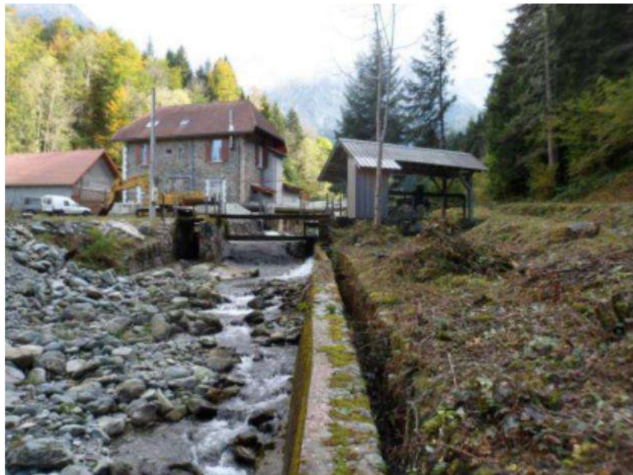
Figure 14 : Centrale hydroélectrique de Pont Rajat sur le Doménon amont (Source : EGIS Eau)
