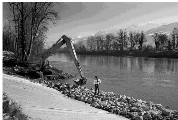
Figure 7 : Photo terrestre des travaux sur l'Isère
