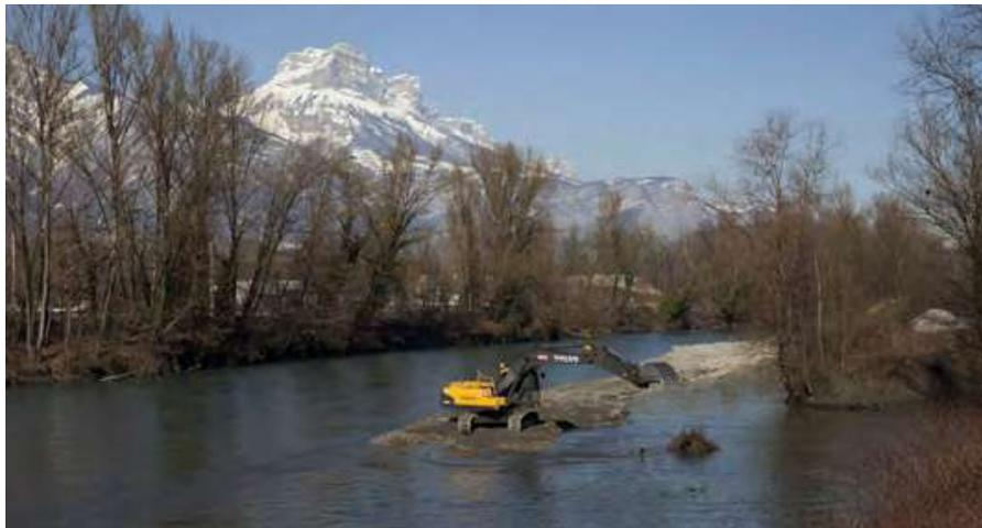
Les travaux du Projet Isère Amont ont consisté à aménager des plages de dépôts. Installées au niveau de ruptures de pentes, ces plages piègent les matériaux transportés par l'eau, qui viennent naturellement s'y déposer. Ces espaces dans l'Isère sont situés entre le pont de Brignoud et le pont de la Bâtie et doivent régulièrement être entretenues. Ces curages permettent de limiter le transit des matériaux dans l'Isère à
