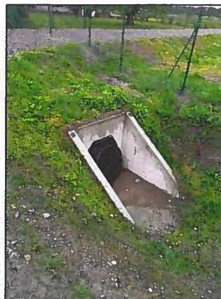
Clapet anti-retour DN800 non remis au Riverain (photographies à titre d'information)
