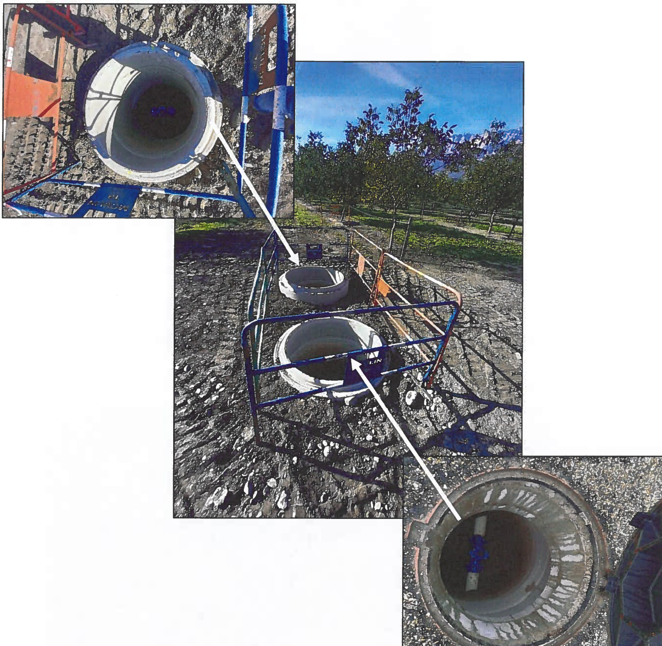
Regards DN1000 et vannes papillon sur réseau d'irrigation
