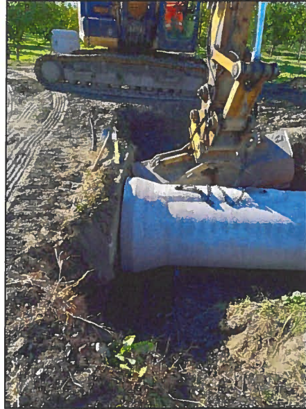
Prolongement busage fossé côté Ouest – Buse béton DN800
