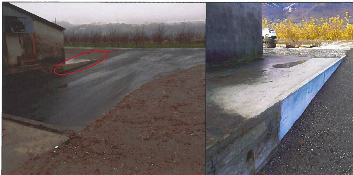
Mur de soutènement préfabriqué
