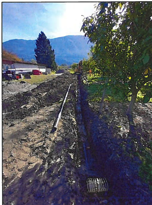
Mise en place de la conduite by-pass DN140 côté SUD
