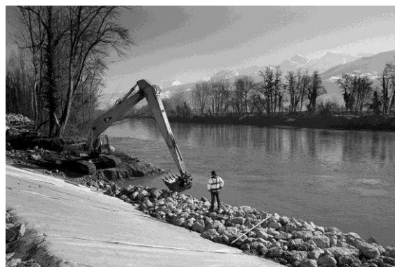
Figure 7 : Photo terrestre des travaux sur l'Isère
