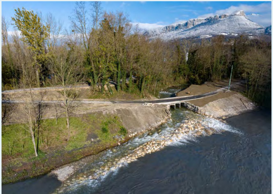
Aménagement piscicole réalisé par le SYMBHI à la confluence du Palluel avec l'Isère. Décembre 2023. Photo © Dupont-Renoux
