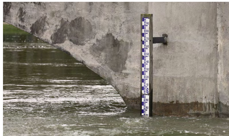
Photo d'une échelle limnimétrique
