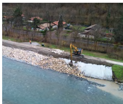
Mise en oeuvre d'une protection de talus de digue en enrochements.
