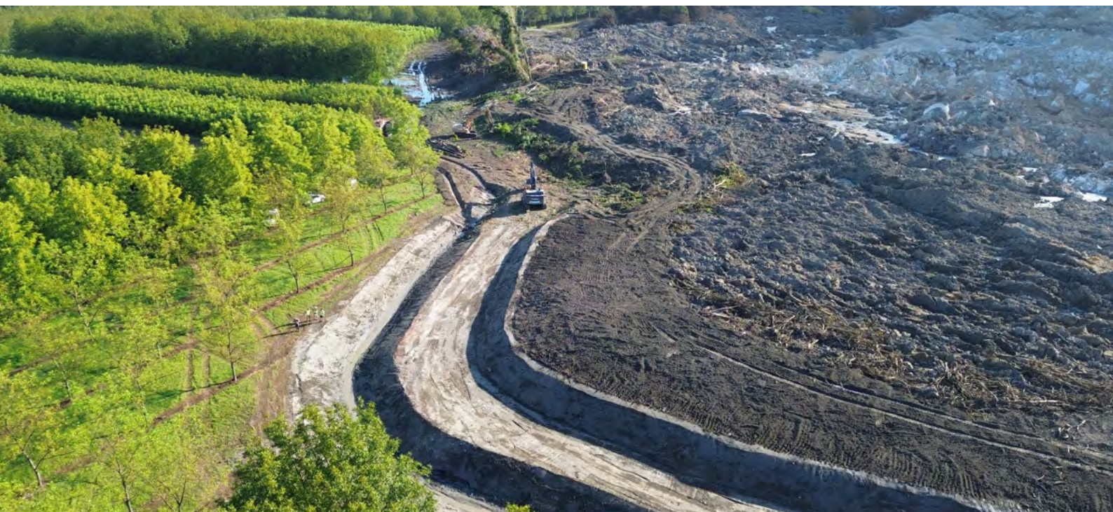
Travaux d'urgence de restauration d'un tracé du Versoud - août 2024
