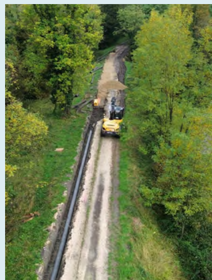
Travaux de remplacement de la conduite du Saumoduc dans la digue de l'Isère en aval de Grenoble
