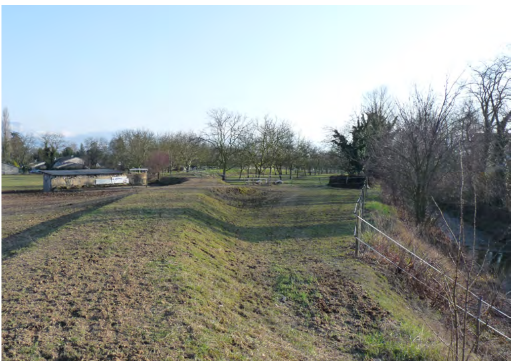
Digue du Fourneau le long du Merdaret à Chatte
