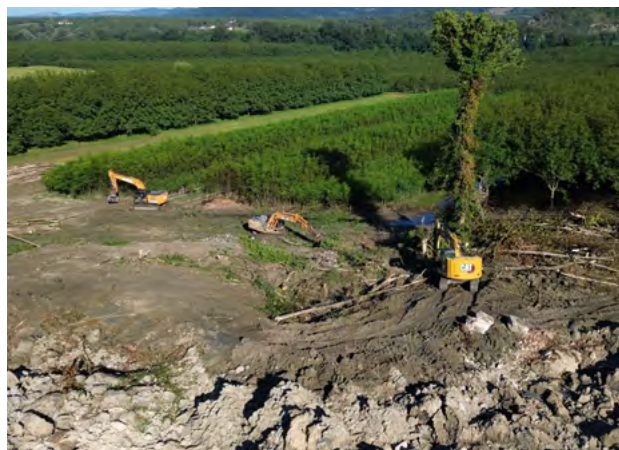
Travaux sur le Versoud à la Rivière après l'éboulement de la carrière – Aout 2024
