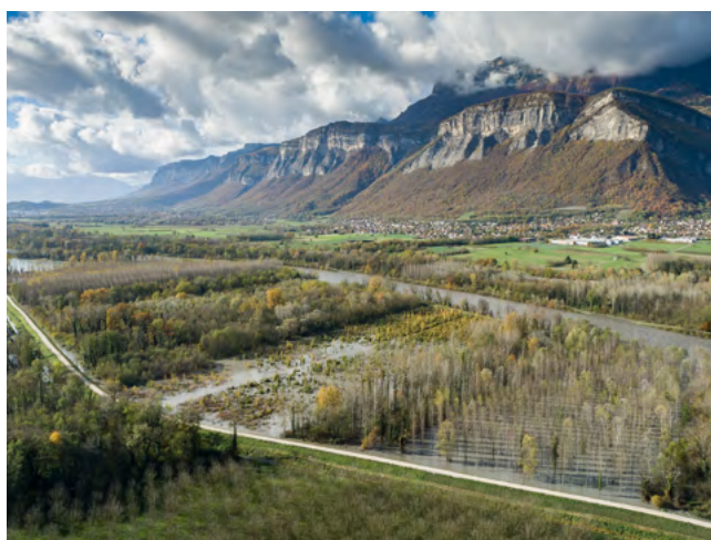
Remise en eau de la forêt alluviale la zone de recul de digues - Novembre 2023
