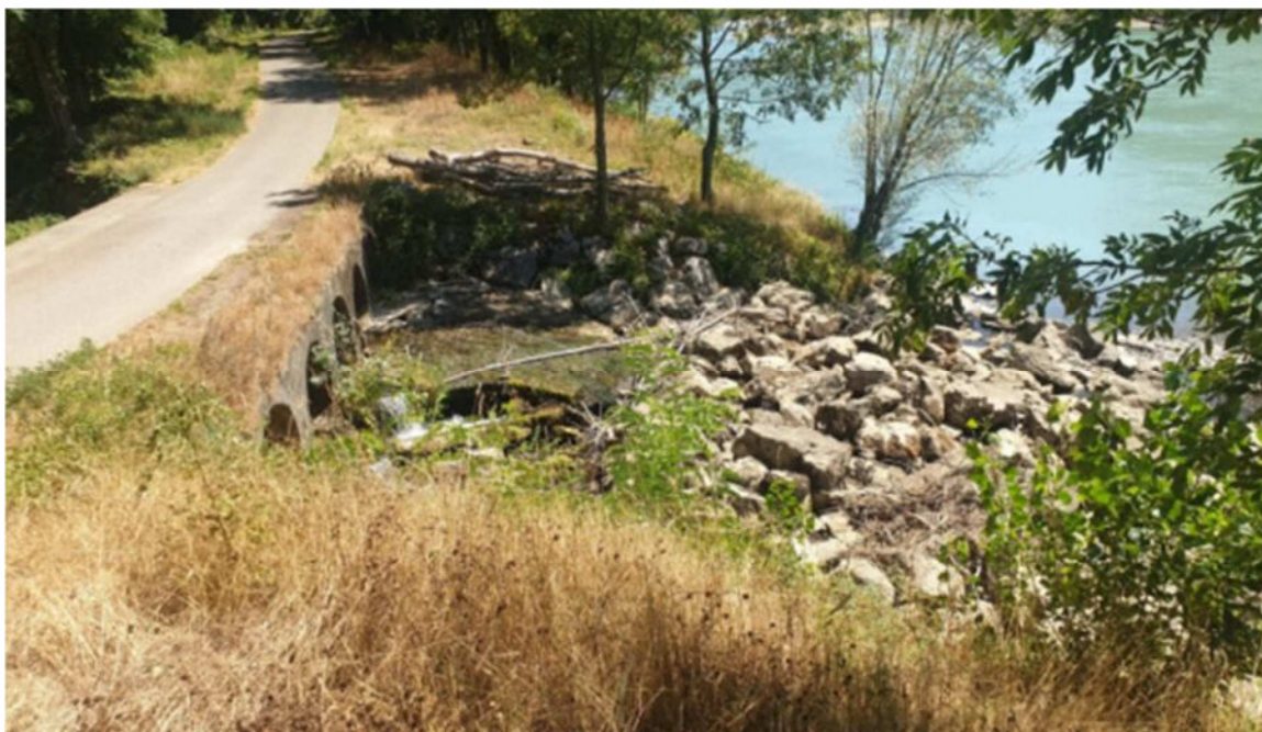
Avant travaux : déconnexion entre le canal du Palluel et l'Isère en raison d'une chute forte et de pentes trop élevées
